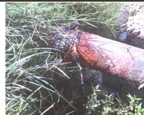
Imagen de salidero en conductora de agua potable
